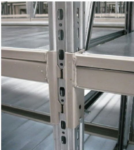
Dettaglio aggancio montante- corrente
